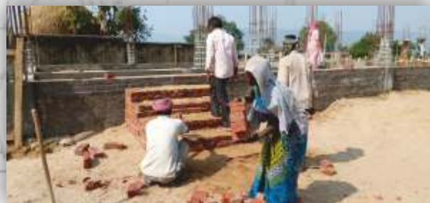
Bauarbeiten in Bartua
